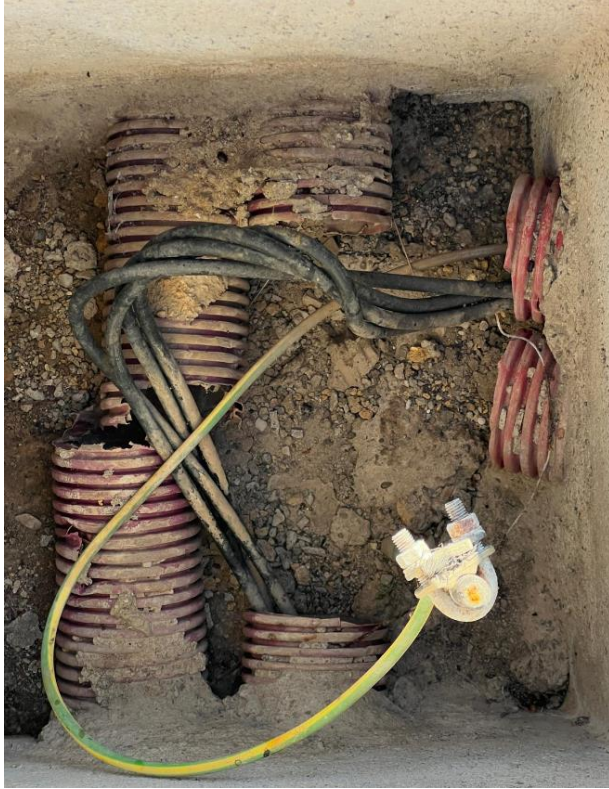
CAMPO DE FÚTBOL-11 DETALLES DE PUESTA A TIERRA.
