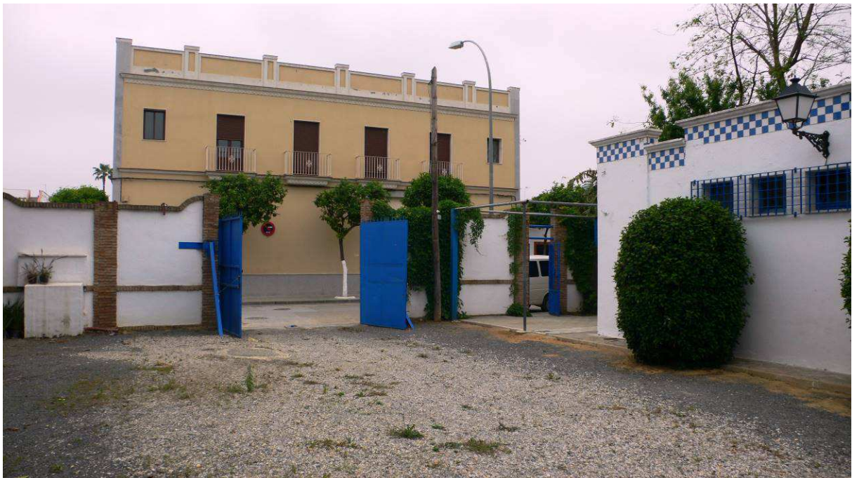
VISTA DESDE EL INTERIOR AL ACCESO
